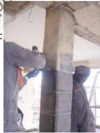
Σχ. Σ6.9β Περίσφιξη με ινοπλισμένα πολυμερή-στρωγγύλευση γονιών
