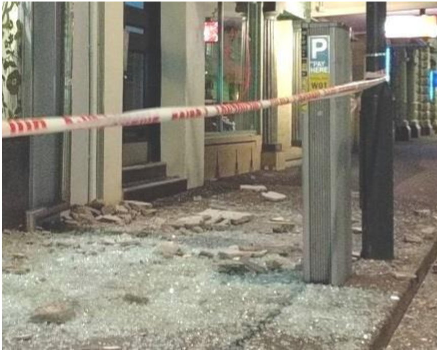
Βλάβες σε υαλοστάσια
