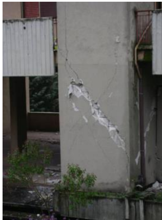
Βλάβες σε τοιχεία από Οπλισμένο Σκυρόδεμα
