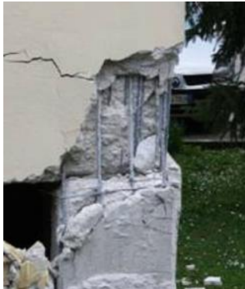
Αστοχία κόμβου δοκού-υποστυλώματος.
