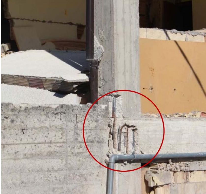
Αστοχία κόμβων δοκού - υποστυλώματος
