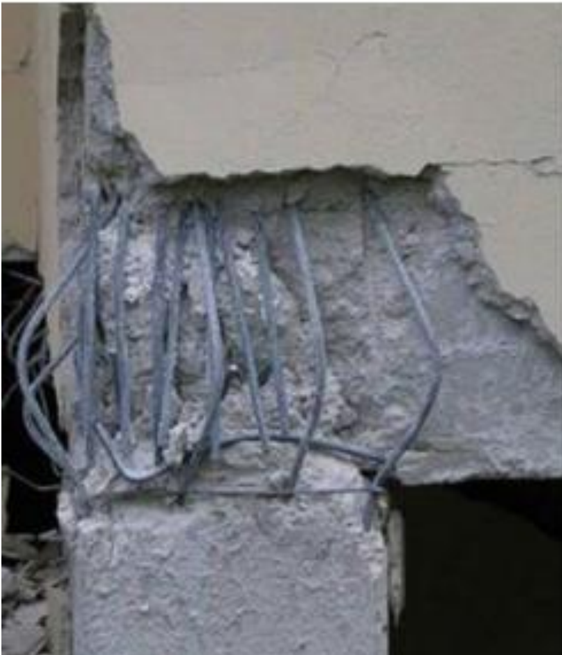
Αστοχία κόμβου δοκού-υποστυλώματος.
