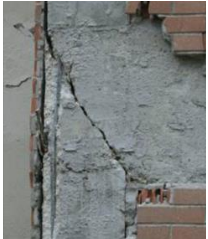
Αστοχία κόμβου δοκού-υποστυλώματος.
