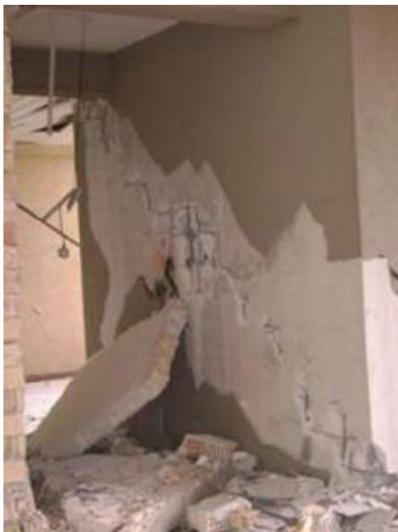
Βλάβες σε τοιχεία από Οπλισμένο Σκυρόδεμα
