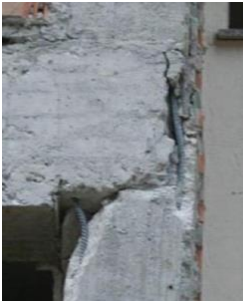
Αστοχία κόμβου δοκού-υποστυλώματος.
