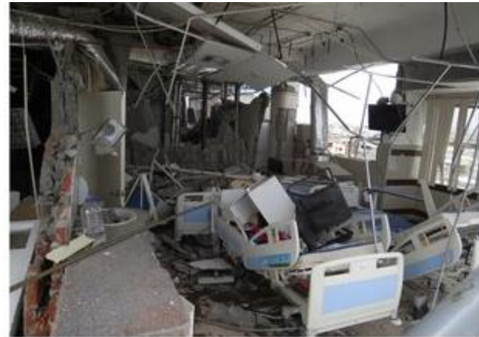
Βλάβες σε νοσοκομείο, 2016 Muisne, Ecuador earthquake
