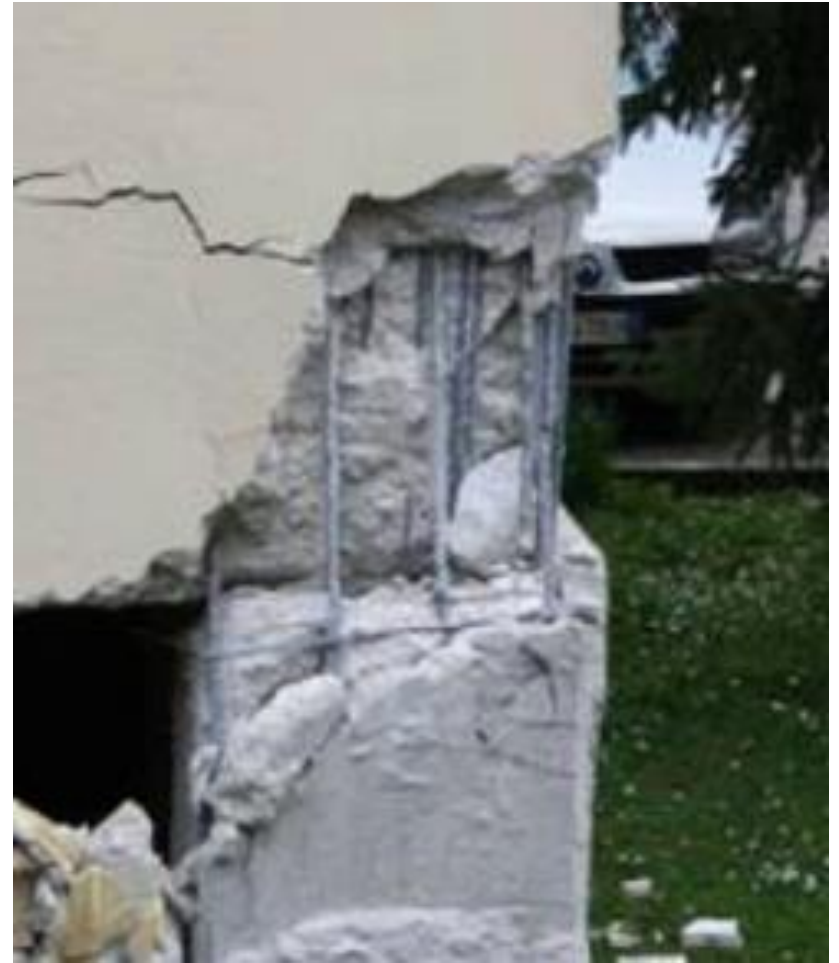
Αστοχία κόμβου δοκού-υποστυλώματος.
