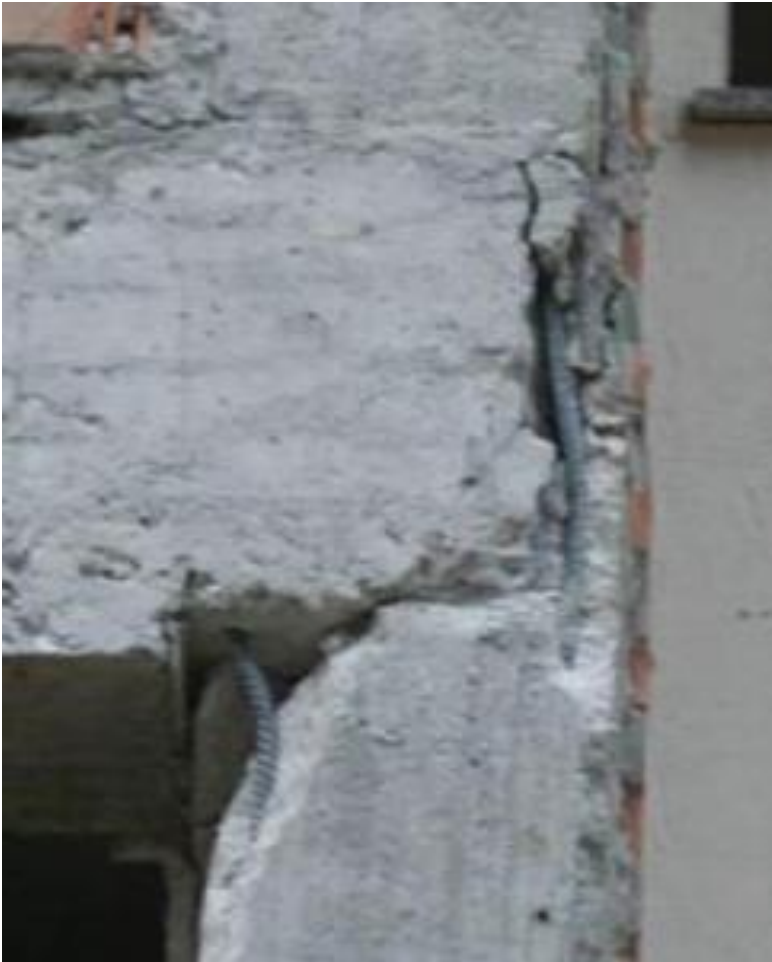
Αστοχία κόμβου δοκού-υποστυλώματος.
