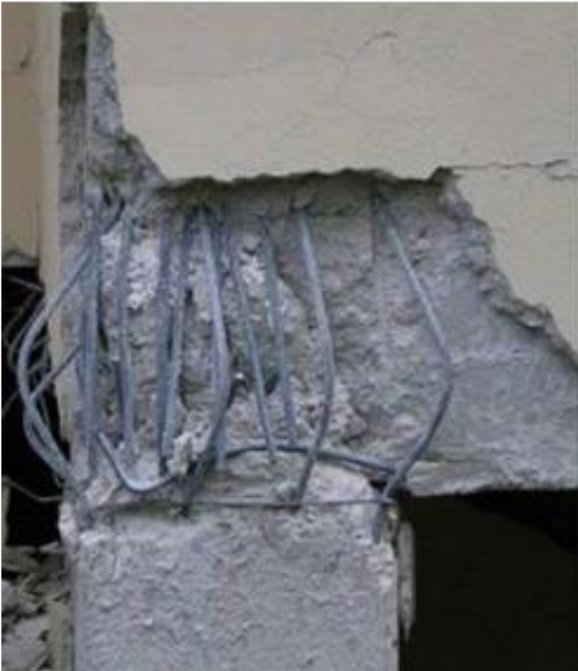
Αστοχία κόμβου δοκού-υποστυλώματος.
