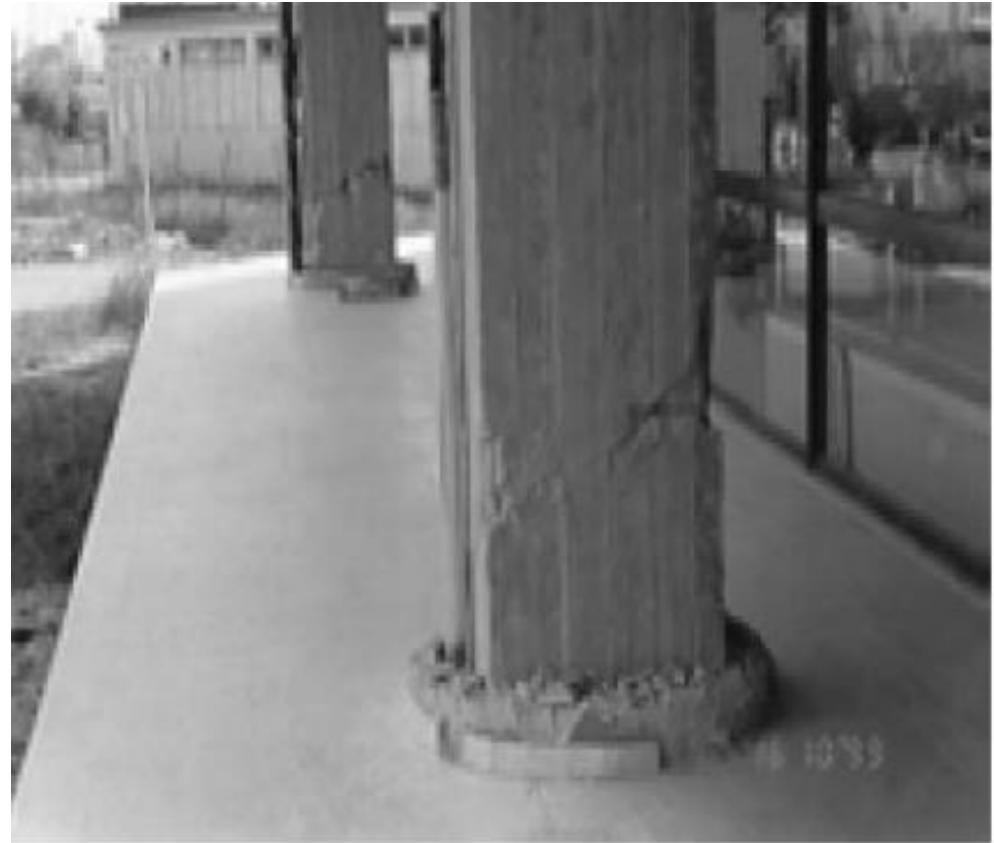
Διατμητική αστοχία υποστυλώματος πάνω & κάτω με λυγισμό ράβδων και θραύση λεπτών & αραιών συνδετήρων
