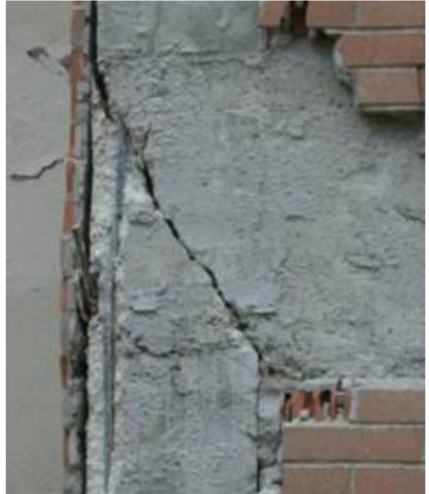
Αστοχία κόμβου δοκού-υποστυλώματος.
