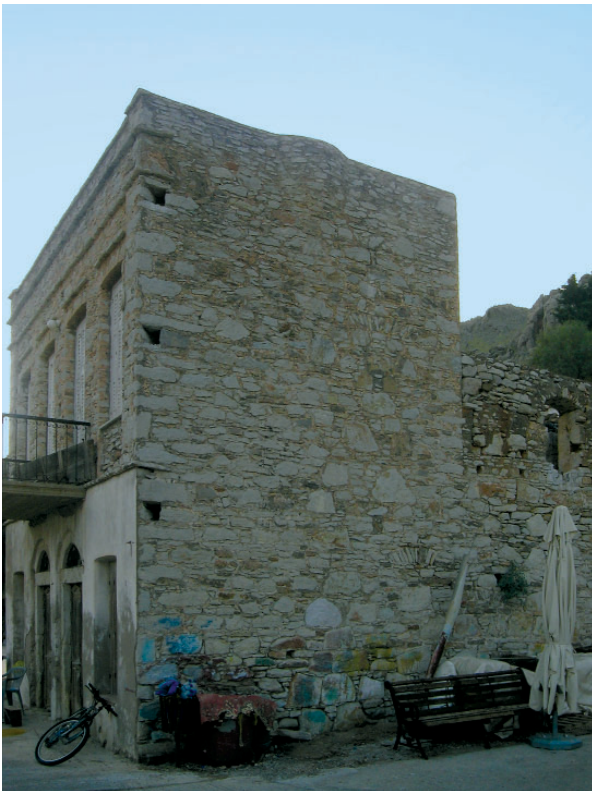
// Διακρίνονται οι οπές για τη στήριξη του ικριώματος
