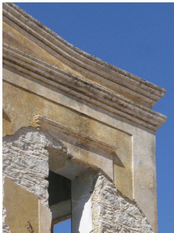
// Λιθοδομή - Επίχρισμα με "τραβηχτό" - ασβεστόδομα
