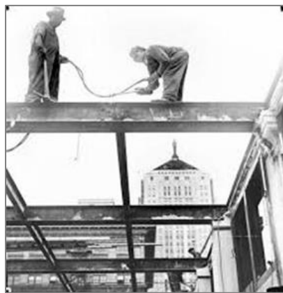
Εικ.22. Ο πρώτος ουρανοξύστης του William le Baron Jenney, (1883-85), Σικάγο, ΗΠΑ, λεπτομέρεια σε κατασκευαστικό στάδιο.
