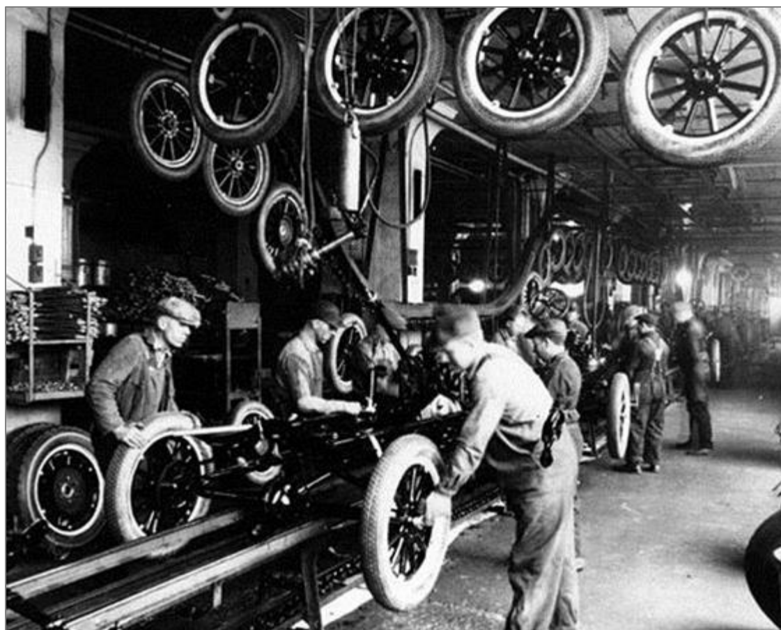
Εικ. 25. Κινούμενη γραμμή συναρμολόγησης του μοντέλου T, της αυτοκινητοβιομηχανίας Ford, το 1913
