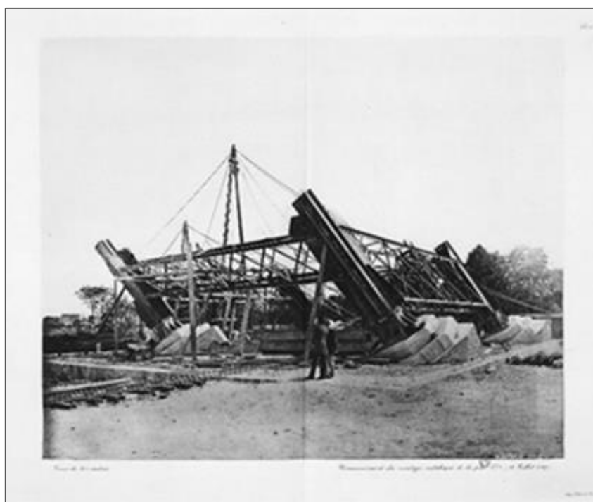
Εικ.17. Πύργος του Eiffel, Παρίσι, 1887, κατά το πρώτο στάδιο κατασκευής του, όπου εργάστηκαν 300 εργάτες για δύο χρόνια, ενώ χρειάστηκαν συνολικά 15.000 μεταλλικά κομμάτια.
