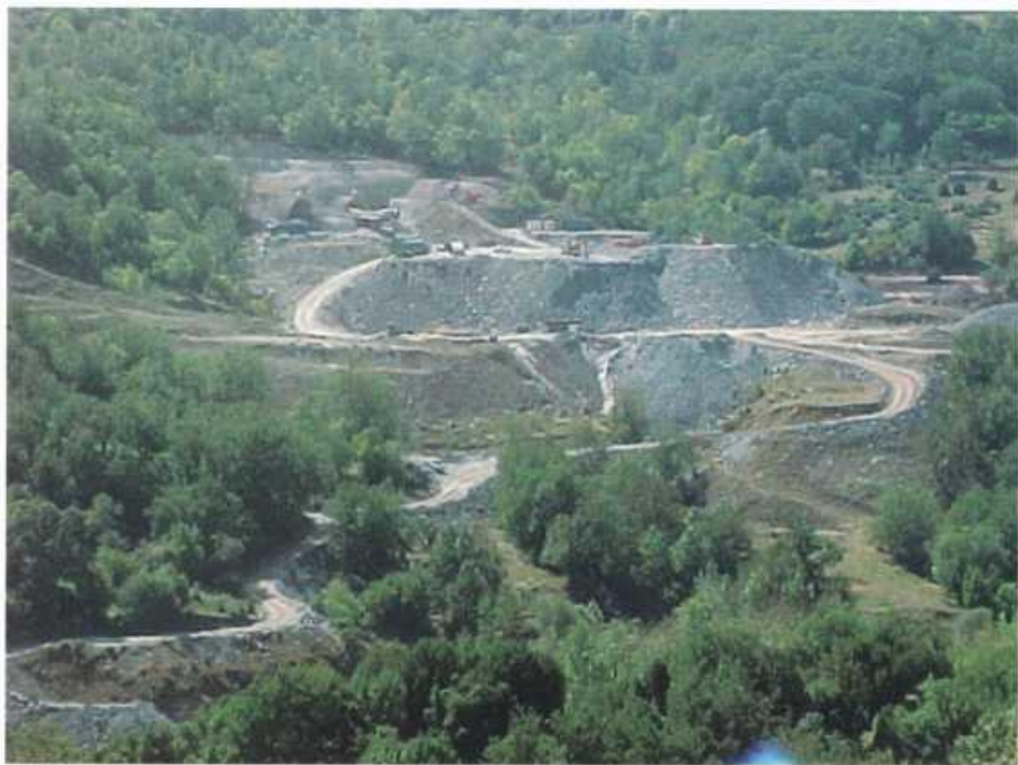
Εικόνα 2. Αποθεσιοθάλαμοι με προϊόντα εκσκαφών οδικής σήραγγας.
