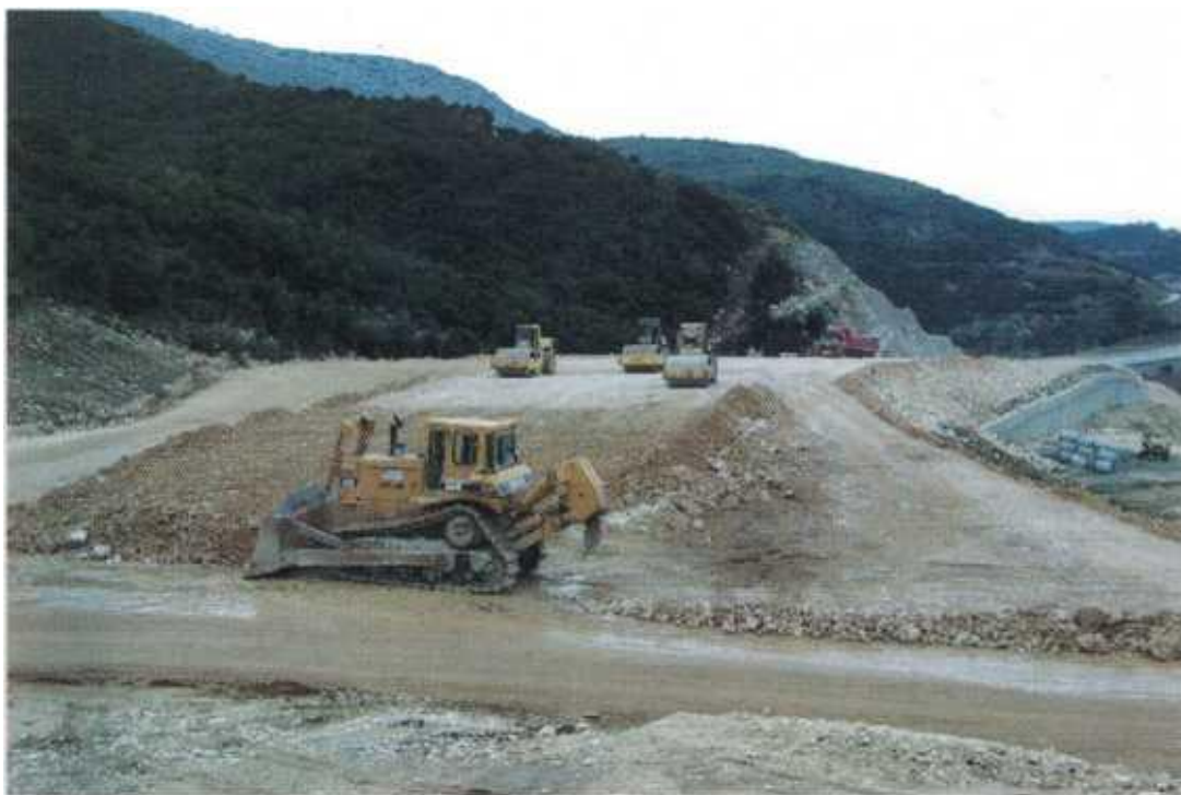
Εικόνα 3. Οδικό επίχωμα σε φάση κατασκευής
