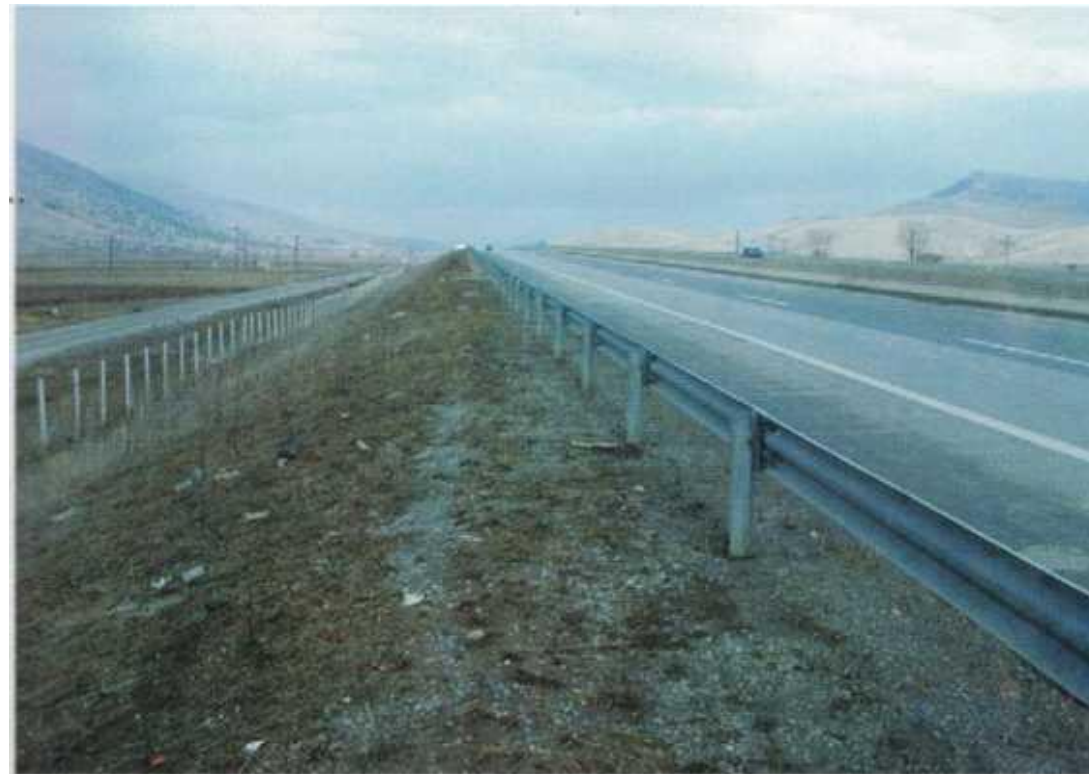
Εικόνα 4. Διατομή αυτοκινητοδρόμου σε επίχωμα.
