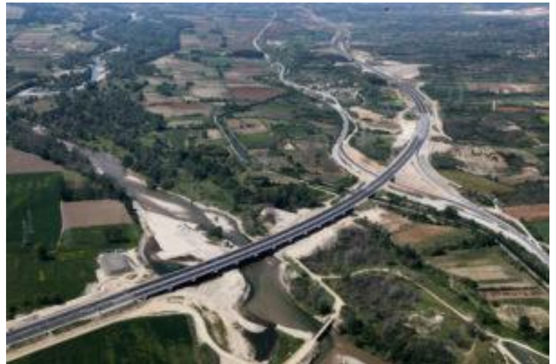
Γέφυρα στον ΝΕΣΤΟ
