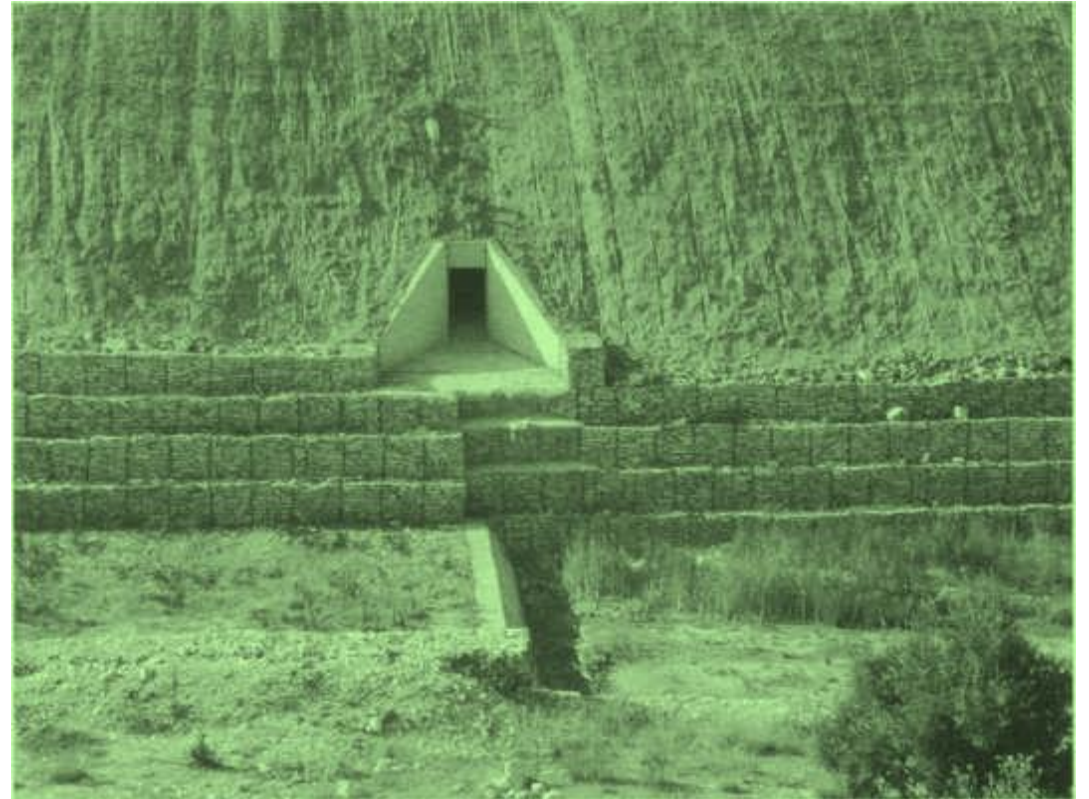
Εικόνα 60. Διατάξεις αντιστήριξης-προστασίας από συρματοκιβώτια
