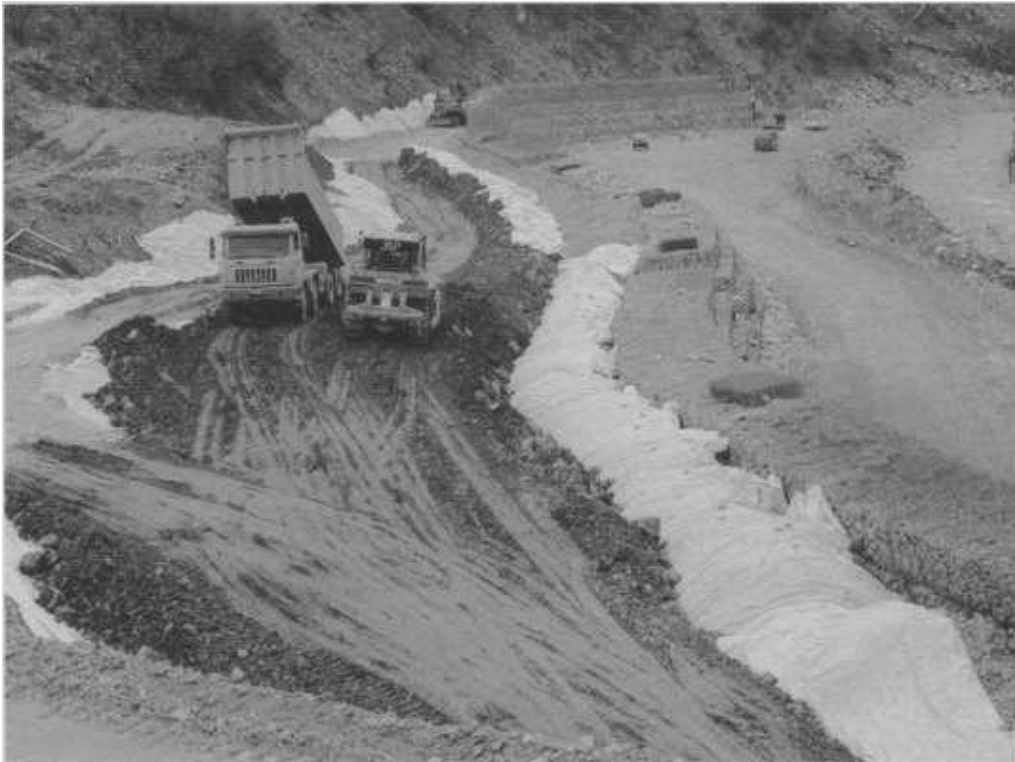
Εικόνα 59. Αντίβαρο ποδός επιχώματος με διάταξη συρματοκιβωτίων
