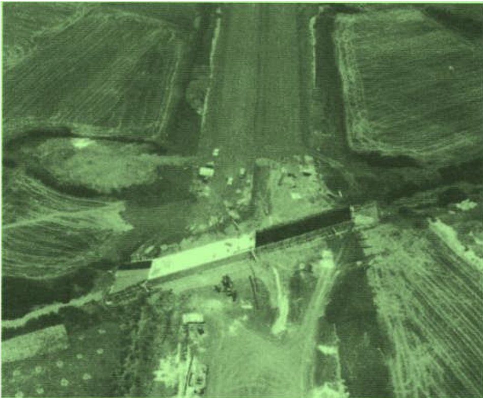
Εικόνα 75. Πλακοσκεπής οχετός σε φάση κατασκευής
