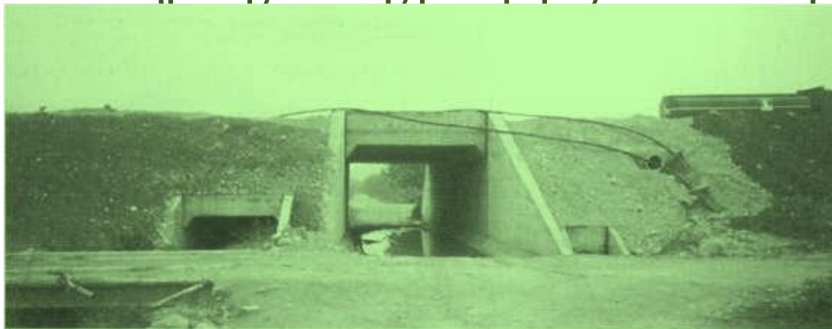
Εικόνα 72. Πρόσοψη εισόδου τεχνικών σε διάταξη. Κιβωτοειδείς, πλακοσκεπείς και σωληνωτοί οχετοί .
