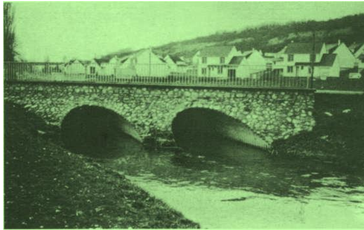
Εικόνα 74. Μεταλλικοί οχετοί
