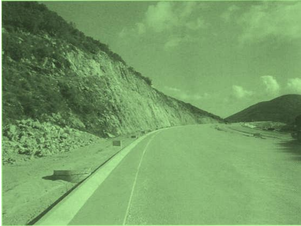
Εικόνα 65. Τριγωνική τάφρος και δίκτυο υπόγειας αποστράγγισης.
