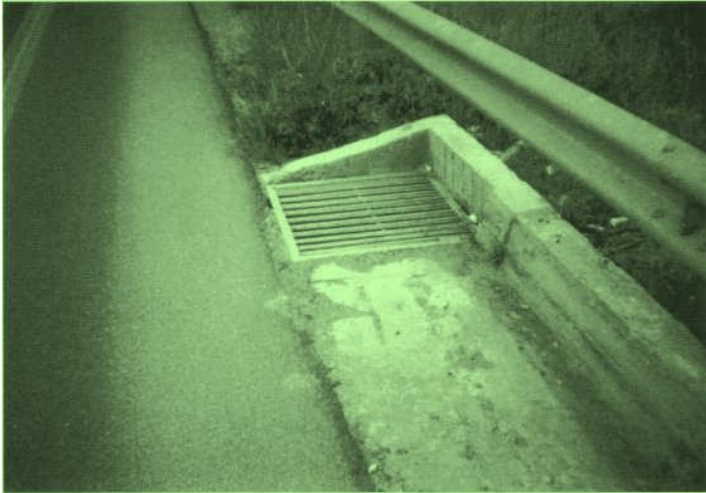
Εικόνα 64. Κρασπεδόρειθρο με φρεάτιο υδροσυλλογής.
