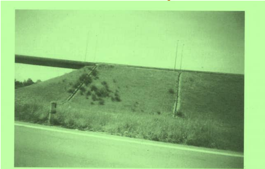
Εικόνα 63· Ρείθρα σε επίχωμα ανισόπεδου κόμβου.
