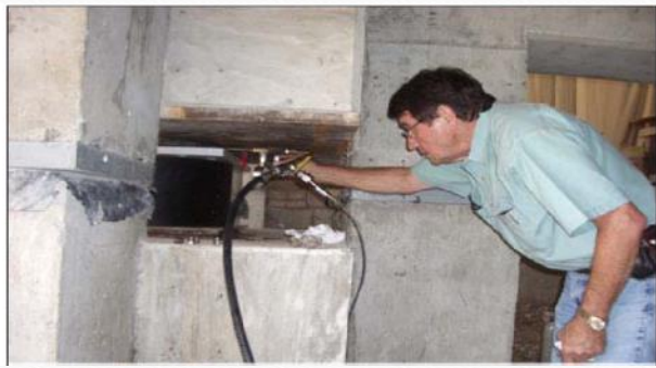
Εγκατάσταση σεισμικού μονωτήρα
