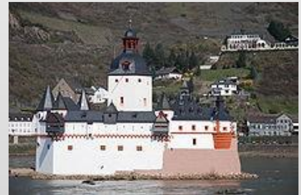
Διόδια στον Ρήνο Κατασκευή: 1174
