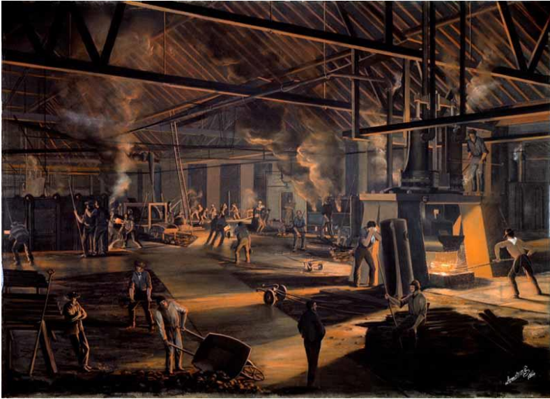
Painting of the Toronto To Rolling Mills, ήταν εργοστάσιο σιδηροτροχιών που ιδρύθηκε το 1857 από μια ομάδα επιχειρηματιών με επικεφαλής τον μεγιστάνα των σιδηροδρόμων Sir Casimir Gzowski. Εκείνη την εποχή, ήταν η μεγαλύτερη σιδηροβιομηχανία στον Καναδά και ο μεγαλύτερος κατασκευαστής στο Τορόντο. Η εισαγωγή χαλύβινων σιδηροτροχιών οδήγησε στο κλείσμό του το 1873.
