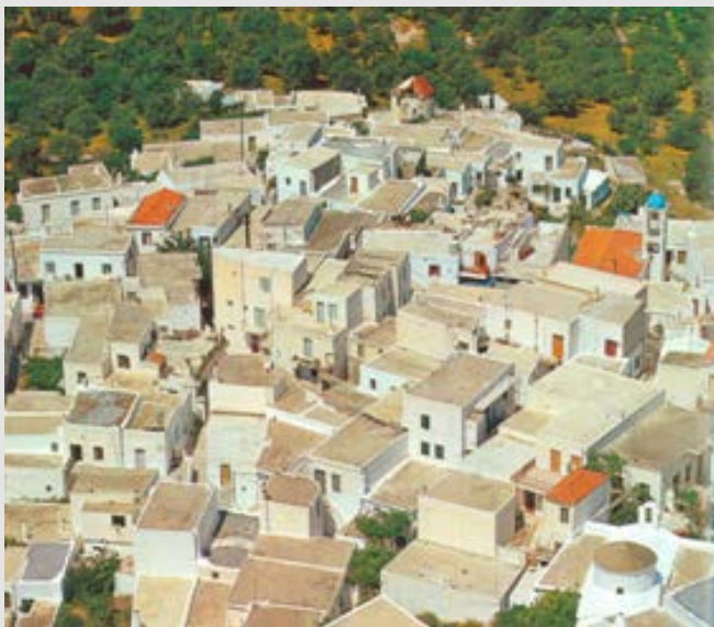
Σχήμα 6.3.1. Τα παραδοσιακά κυκλαδίτικα σπίτια είναι βαμμένα άσπρα για να αποφεύγεται η επιπλέον υπερθέρμανση
