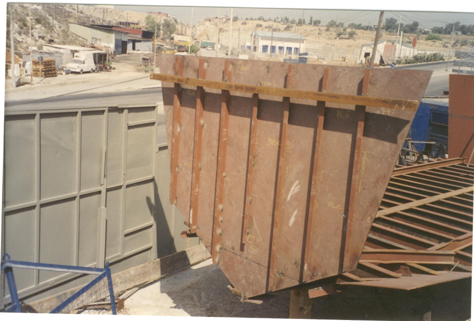
Τοποθέτηση εγκάρσιων φρακτών (νομέας 10 και νομέας 30)
