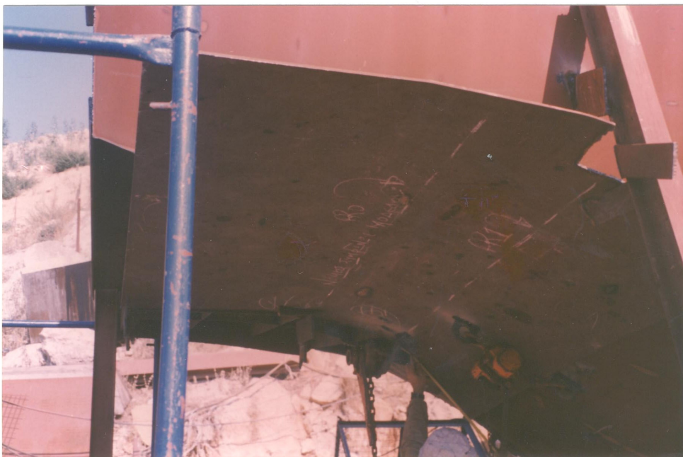
Τοποθέτηση ελασμάτων πυθμένα στην περιοχή του πρυμναίου στεγανού.
