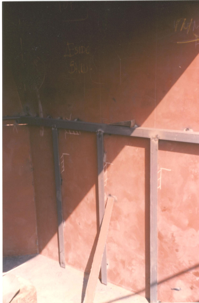
εσωτερικό γέφυρας (πλευρική φρακτή)
