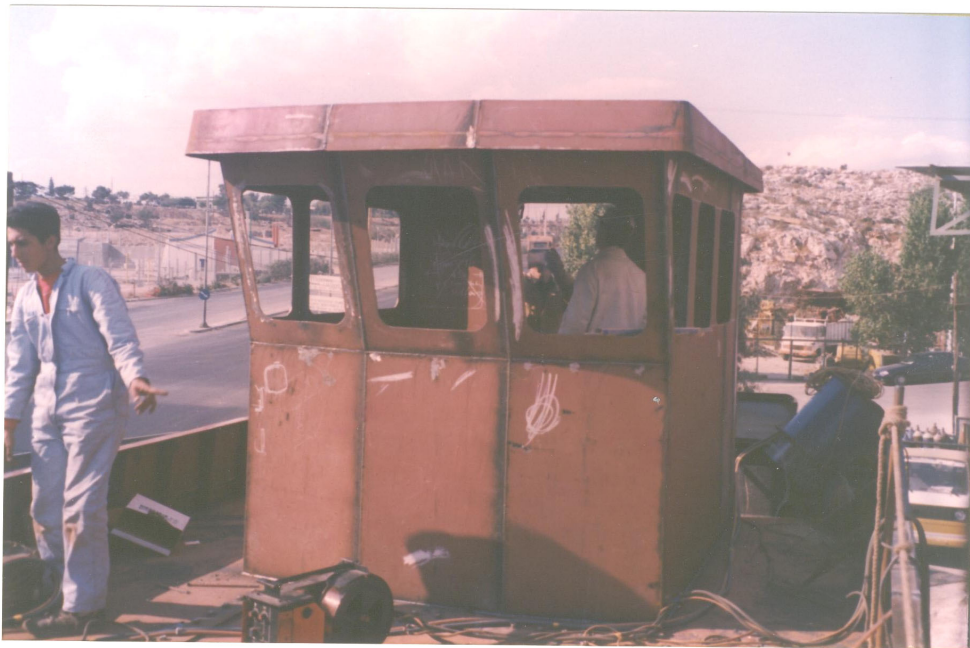
Κατασκευή και προσαρμογή γέφυρας.
