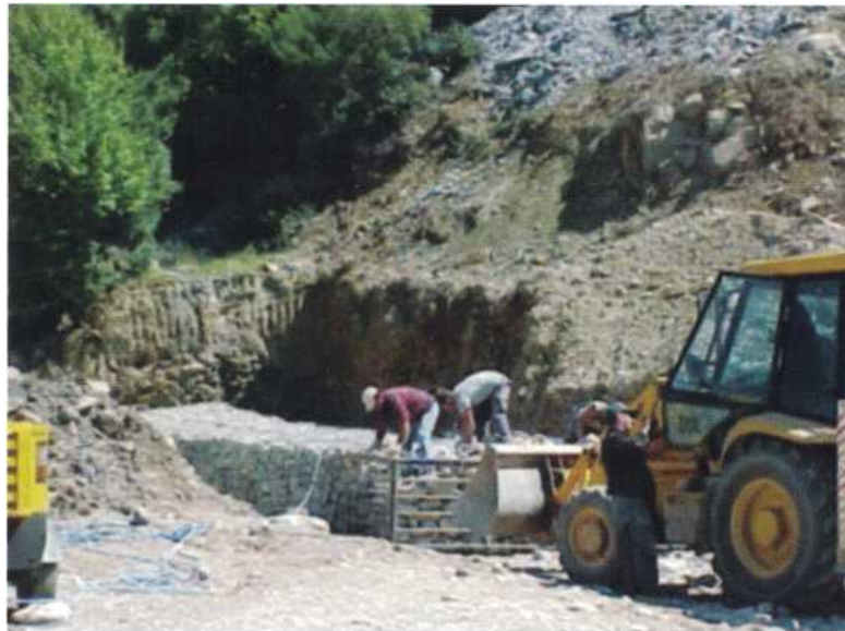
Εικόνα 42. Κατασκευή αντίβαρου ποδός από συρματοκιβώτια.
