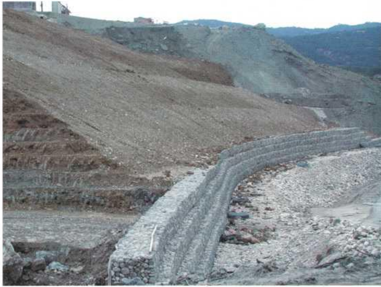
Εικόνα 41. Ενίσχυση ποδός επιχώματος.
