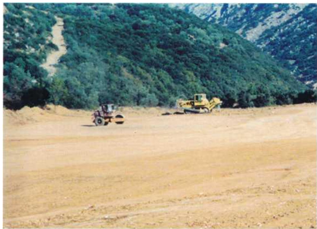
Εικόνα 40. Κατασκευή οδικού επιχώματος.
