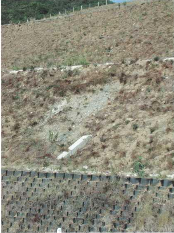
Εικόνα 36. Πρανές ορύγματος με δύο ενδιάμεσους αναβαθμούς και επένδυση με γεωκυψέλες.
