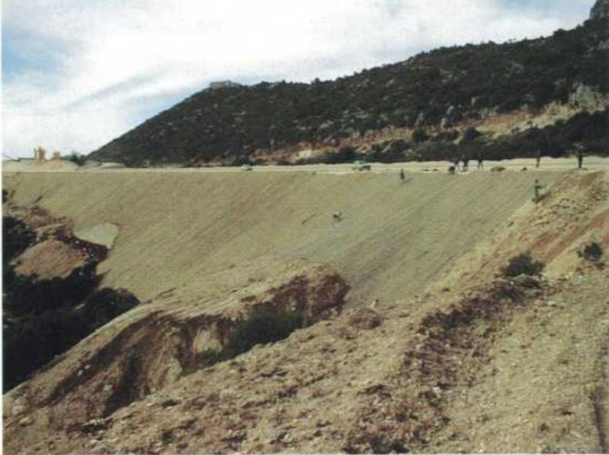
Εικόνα 39. Κατασκευή επιχώματος επί κλιτύος.
