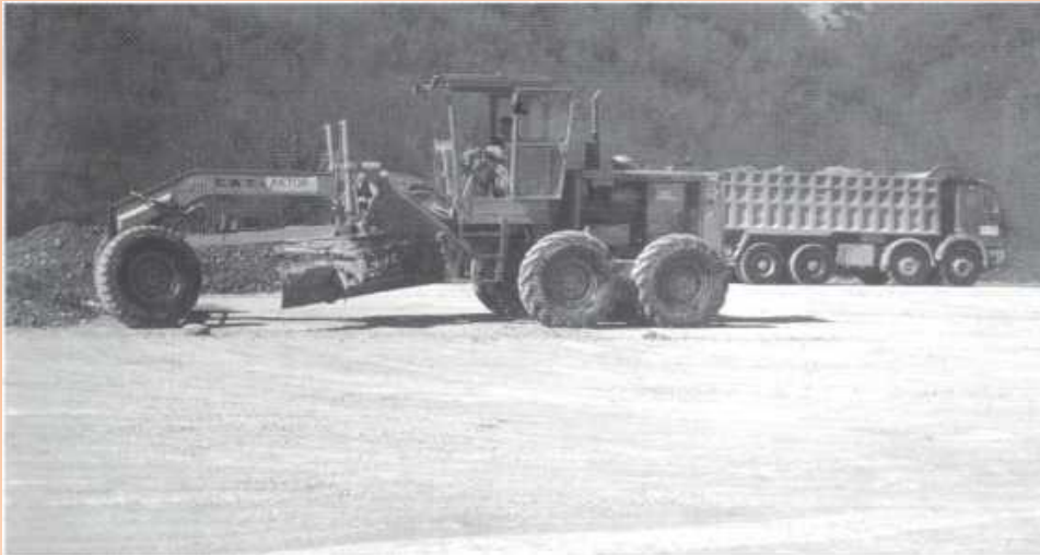
Εικόνα 24. Μόρφωση επιχώματος από ισοπεδωτή
