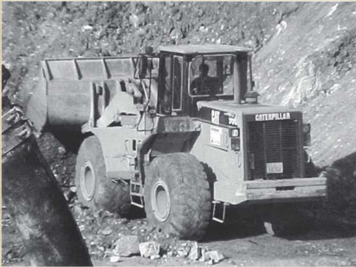
Εικόνα 26. Φορτωτής σε εργασίες επιχωμάτωσης.
