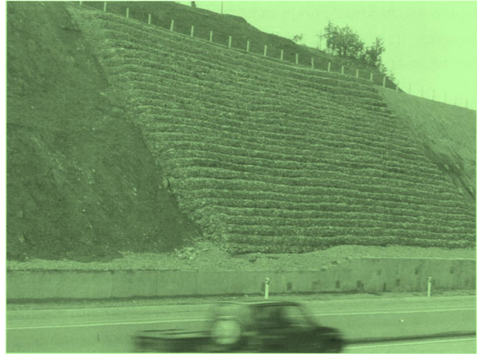
Εικόνα 17. Επένδυση πρανούς ορύγματος με συρματοκιβώτια
