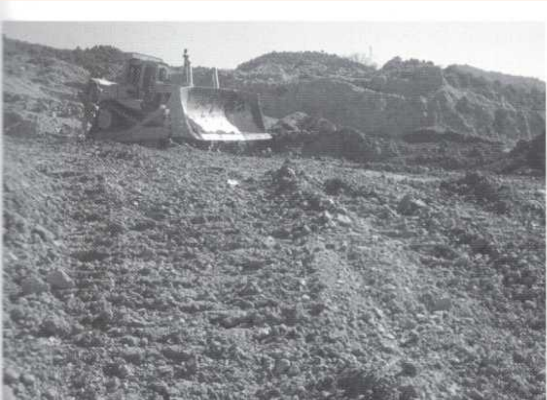
Εικόνα 20. Προωθητής σε εκσκαφή και επίχωση
