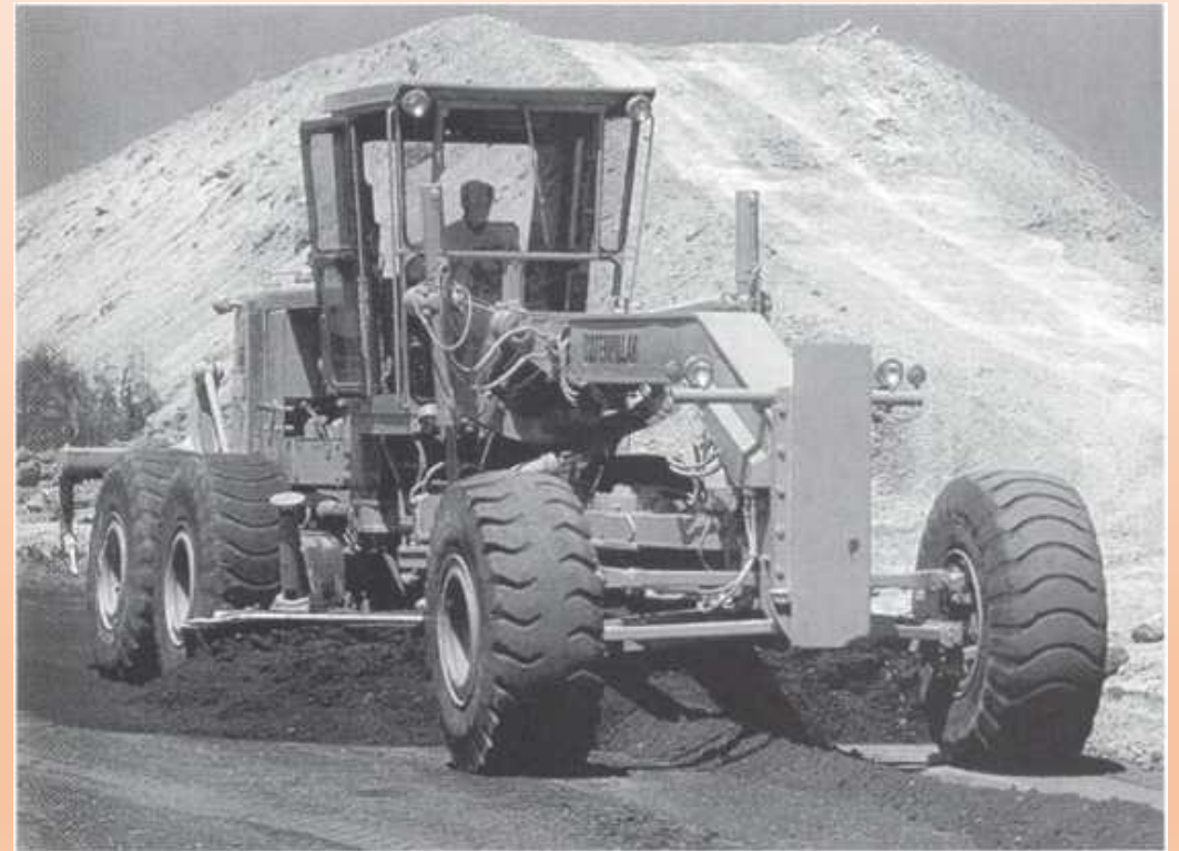
Εικόνα 23. Διάστρωση αργιλοχαλικώδους υλικού από ισοπεδωτή
