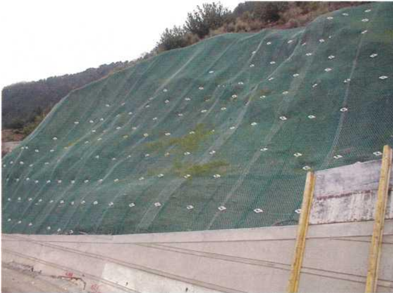
Εικόνα 50. Φυτικό γεώπλεγμα προστασίας πρανών.
