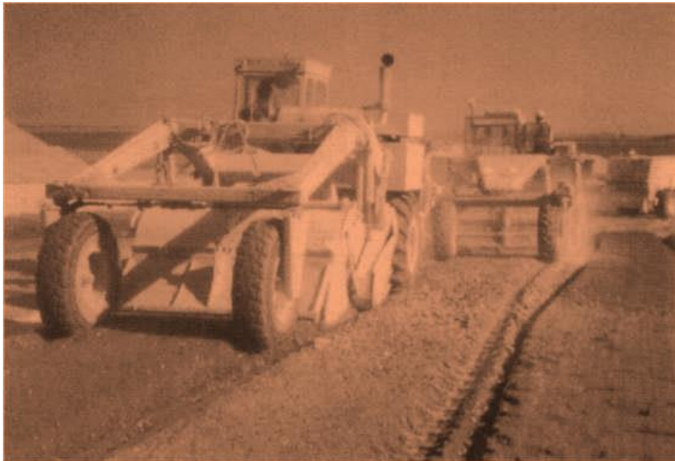
Εικόνα 44. Διάσθρωση υδρασβέστου για σταθεροποίηση υλικού επίχωσης [39].
