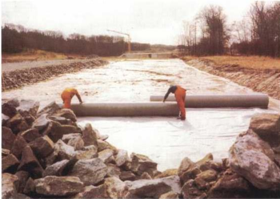
Εικόνα 49. Διάστρωση γεωφάσματος σε εξυγιαντική κλίνη.
