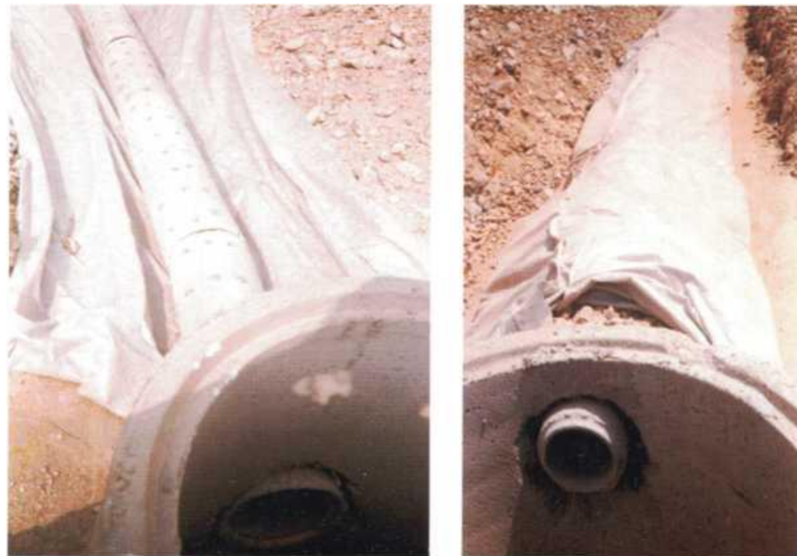
Εικόνα 48. Τοποθέτηση γεωφάσματος σε αγωγό στραγγιστηριού.
