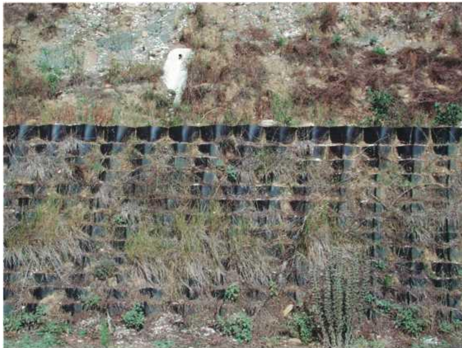
Εικόνα 46. Γεωκυψέλες για επένδυση πρανούς.
