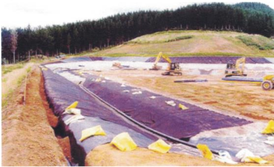
Εικόνα 47. Γεωφάσμα σε θέσεις έδρασης Επιχώματος και σε έργα αποστράγγισης
