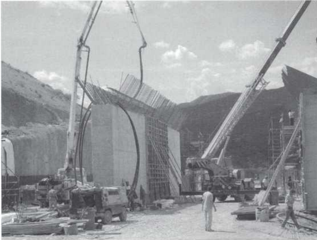
Εικόνα 56. Κατασκευή φορέα σήραγγας “cut and cover”
