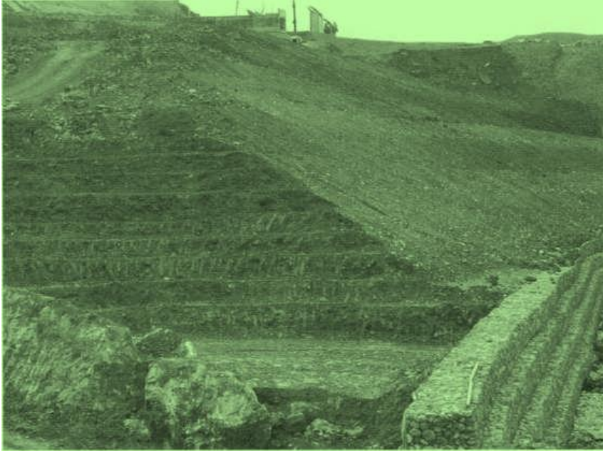
Εικόνα 53. Συρματοκιβώτια στον πόδα επιχώματος.
