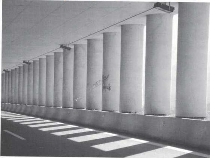
Εικόνα 58. Εσωτερικό οδικού ημιστέγαστρου
