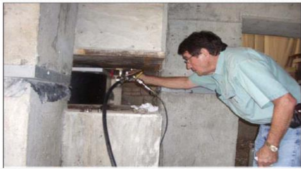
Εγκατάσταση σεισμικού μονωτήρα
