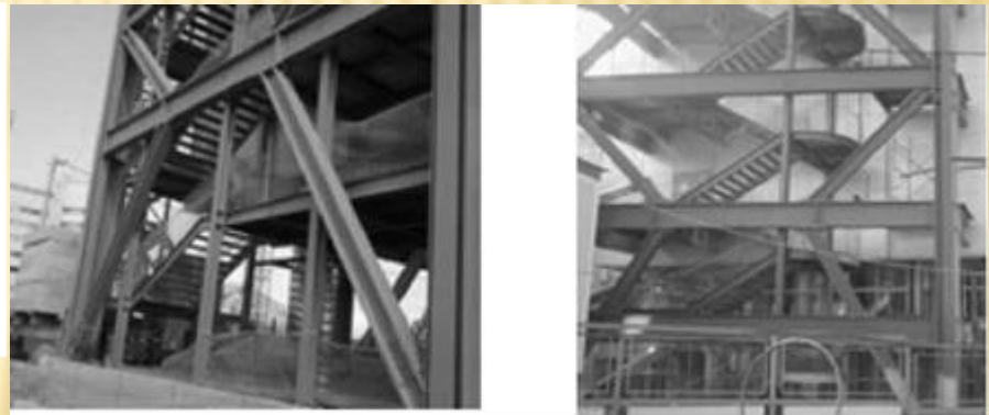
Σχήμα 25: Εφαρμογή δικτυωτών συνδέσμων με εκκεντρότητα στο Κέντρο Τύπου των Ολυμπιακών Αγώνων του 2004.
