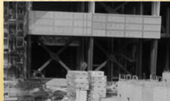
Σχήμα 23: Αντισεισμική ενίσχυση κατασκευής με χιαστί διαγώνιους συνδέσμους
