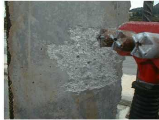
Προετοιμασία Επιφάνειας με Αεροματσάκονο
