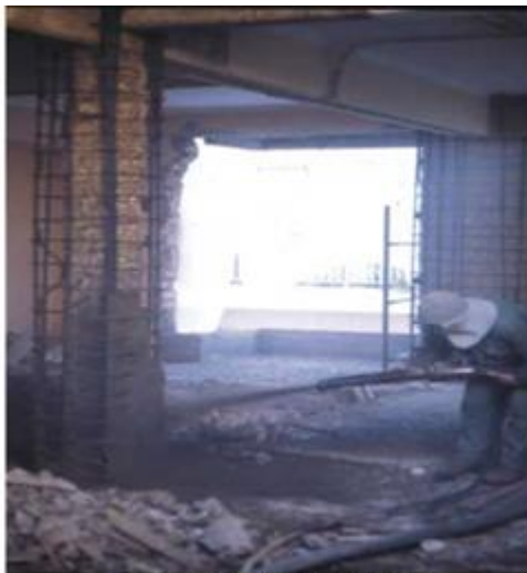
Εκτόξευση Μανδύα Υποστύλιματος
