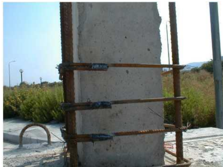
Ηλεκτροσυγκόλληση Ακρων Συνδετήρων Μανδύα 23
