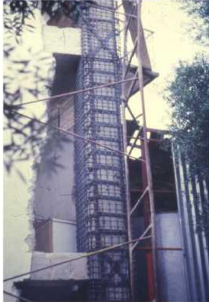
Περίσφιξη με Μεταλλικό Κλωβό
