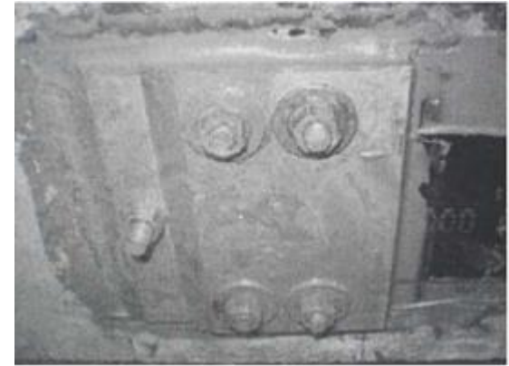
Σχήμα 2 : Εφαρμογή της αγκύρωσης
