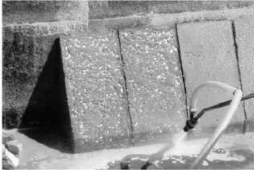
Εκτράχυνση με Αμμοβολή
