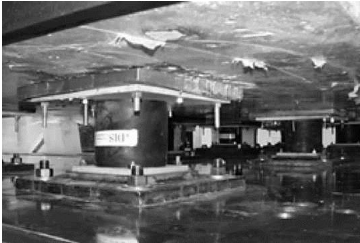
Ελαστομερές εφέδρανο χαμηλής απόσβεσης (κοινό ελαστομεταλλικό εφέδρανο - ELB).
