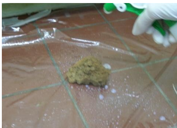
Εικόνα 7.3 Εφαρμογή υλικού κατεργασίας με ψεκασμό.
