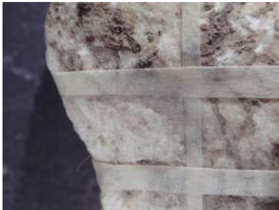
Σχήμα 7.18. AK 4014. Περιοχή καθαρισμού 1
