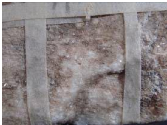
Σχήμα 7.169. ΑΚ 4406. Περιοχή 3 μετά τον καθαρισμό, καθαρισμός με επίθεμα τύπου MORA, χρόνος εφαρμογής 15 λεπτά
