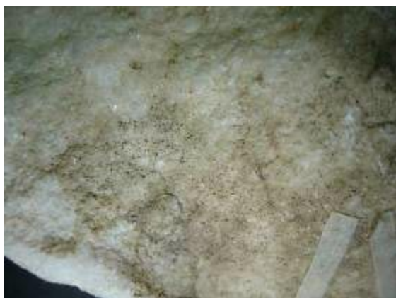
Σχήμα 7.65. AK 4232. Περιοχή 4 πριν τον καθαρισμό. Αργιλοπυριτικές και σιδηρούχες αποθέσεις μικρού πάχους
