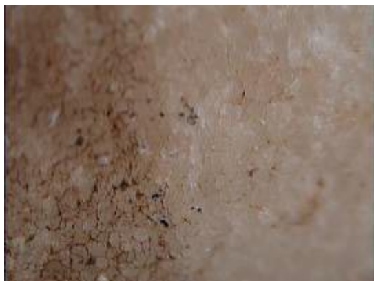
Σχήμα 7.241. ΑΚ 3295. Στερεοσκοπική παρατήρηση x6,7. Μετά τον καθαρισμό με ατμοβολή. Δεξιά διακρίνεται η περιοχή στην οποία εφαρμόστηκε η δοκιμή.
