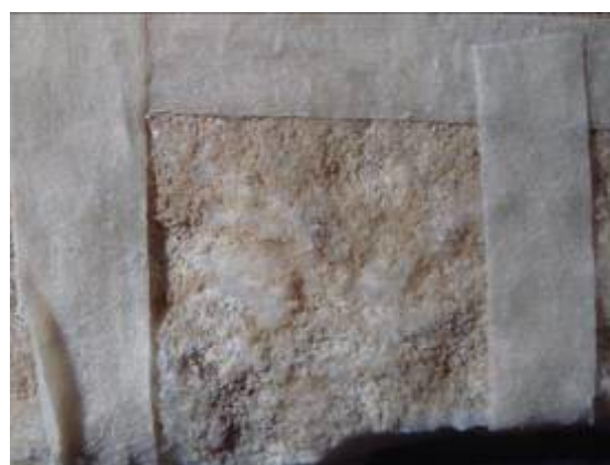
Σχήμα 7.198. ΑΚ 4427. Περιοχή 2 μετά τον καθαρισμό
