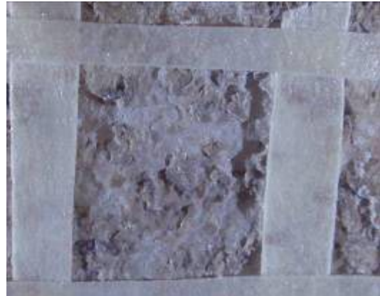
Σχήμα 7.94. ΑΚ 4232. Μετά την επέμβαση καθαρισμού, macro-φωτογράφιση
